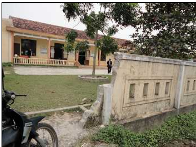
左：クアン・トラク地域トゥエン・ホアコミュニティの幼稚園。 洪水で塀が崩壊した。 右：水が矢印部分まで。教師が被災当時の様子を説明。
