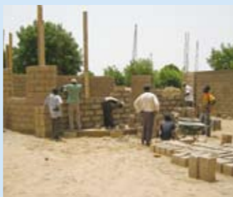
マリでの校舎建設工事の様子。地域の人も熟練技術を要さない作業を積極的に行っています
